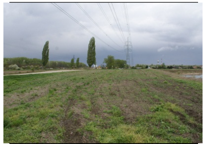
Az út mentén haladó 120 kV-os távvezeték
